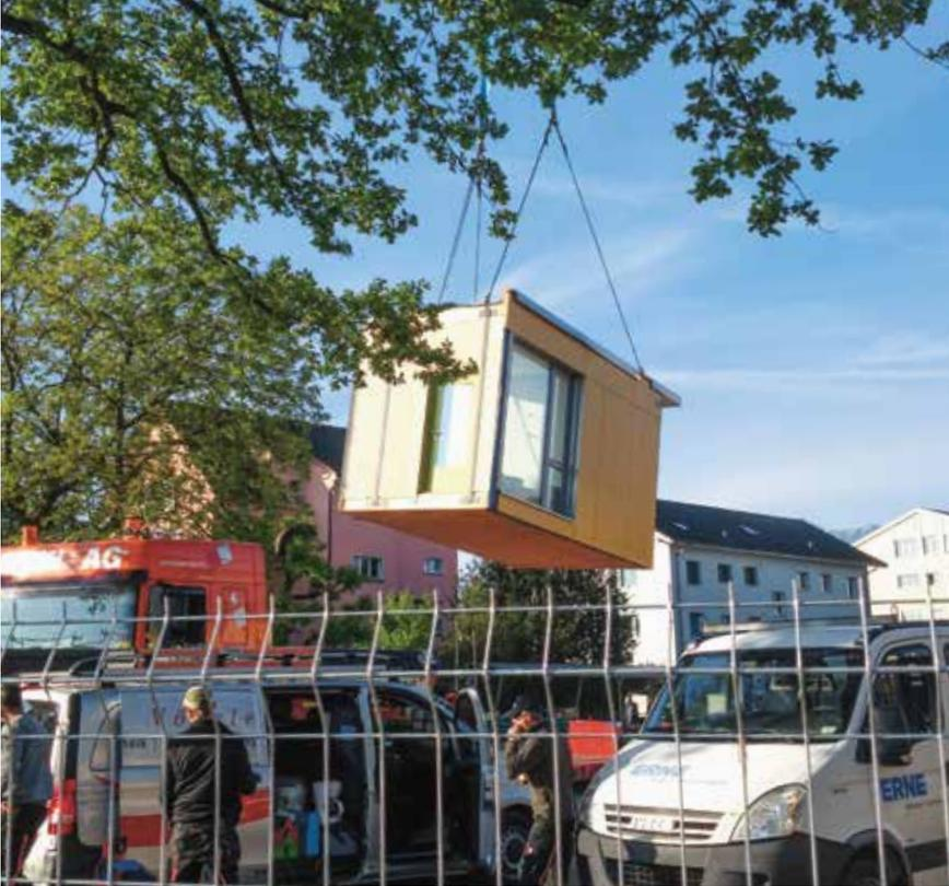
Praktisch: Der Pavillon wurde als Baukastensystem konstruiert und konnte daher schnell aufgebaut werden.
