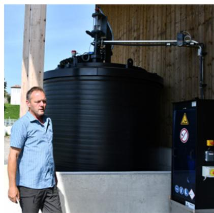
Alois Niederberger beim zehn Tonnen fassenden Tank, gefüllt mit Schwefelsäure. Daneben sichtbar die vollautomatische Dosierungsanlage.
