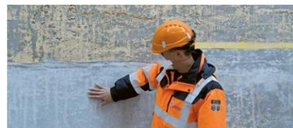
Unterschied vor und nach Abschleifung des Zementmörtels. Oben sind die Auskerbungen noch sichtbar.
