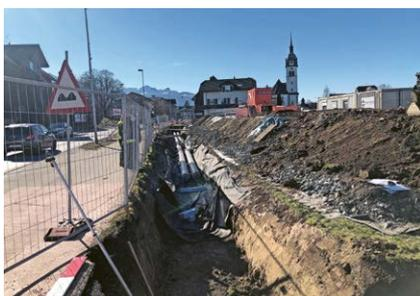
In mehreren Bauetappen wird derzeit das Fernwärmenetz in Emmen Dorf ausgebaut. (Bild: ewl)
