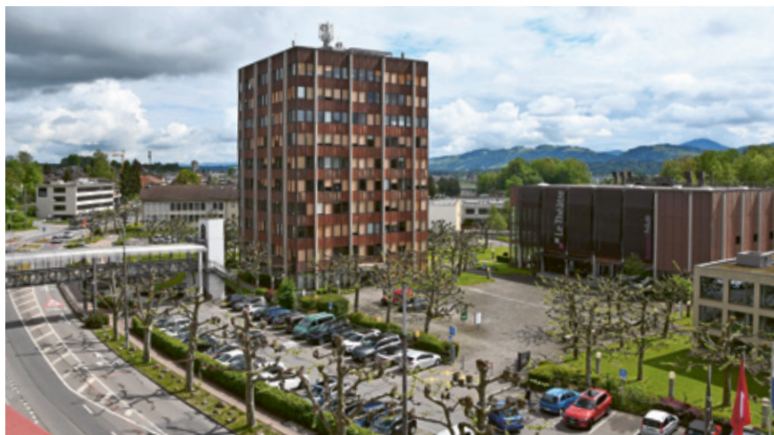
Das Verwaltungsgebäude ist in die Jahre gekommen und soll saniert werden. (Bild: pbu)
