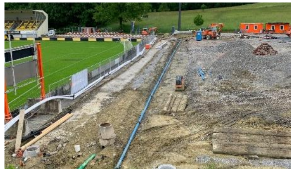
Verlegung und Ersatz Wasserleitung – Juni 2023
