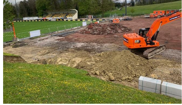
Rückbau Grusplatz – Mai 2023
