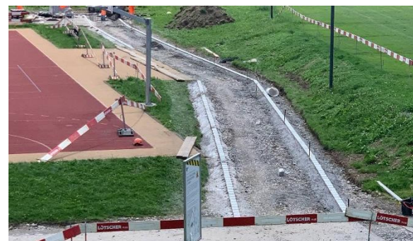
Verlegung Fussweg – August 2023
