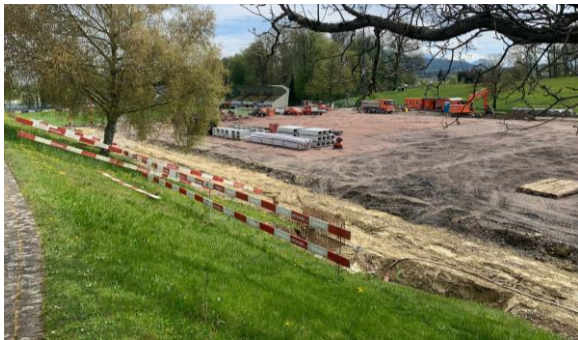
Tiefbauarbeiten – Mai / Juni 2023
