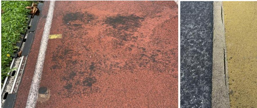
Abbildung 14: Belagsschäden Laufbahn und Aussenplätze
