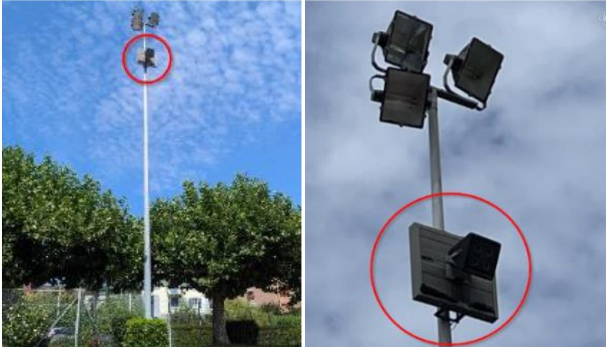
Abbildung 17: Kandelaber mit Schallschutzplatten und Lautsprecher
