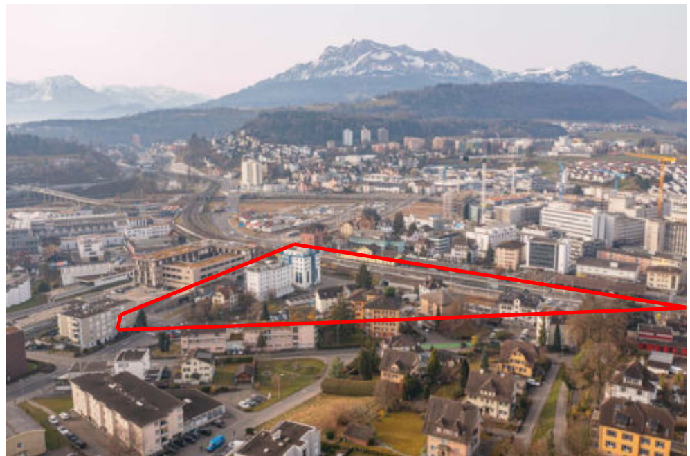
Abb. Aufnahme Planungsgebiet mit Entwicklungsgebiet um den Seetalplatz (Quelle: Thomas Erni Media)
