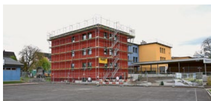
Der Abschluss der Bauarbeiten auf der Schulanlage Riffig wird mit einem öffentlichen Eröffnungs-event gefeiert. (Bild: pbu)
