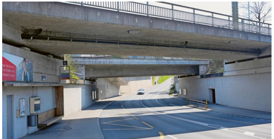
Die beiden Brücken und der Zugang zum Bahnhof Emmenbrücke Kapf werden saniert. (Bild: pbu)
