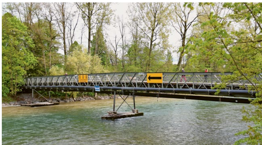
Angehende Bauingenieurinnen und -ingenieure der HSLU nehmen sich der Sedelbrücke als Studienobjekt an. (Bild: pbu)
