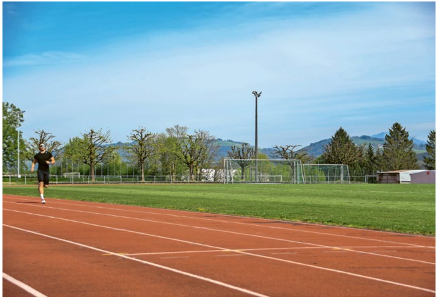
Ab August 2025 wird die Leichtathletikanlage Gersag umfassend saniert – mit neuem Belag, LED-Beleuchtung und moderner Beschallung. (Bild: msc)
