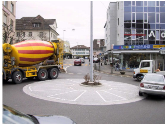
Beispiel Wohlen AG: mit dem Kleinkreis (Durchmesser 21m) wird ein stark frequentierter Verkehrsknoten zu einem attraktiven Zentrumsbereich (Bild vdw)
