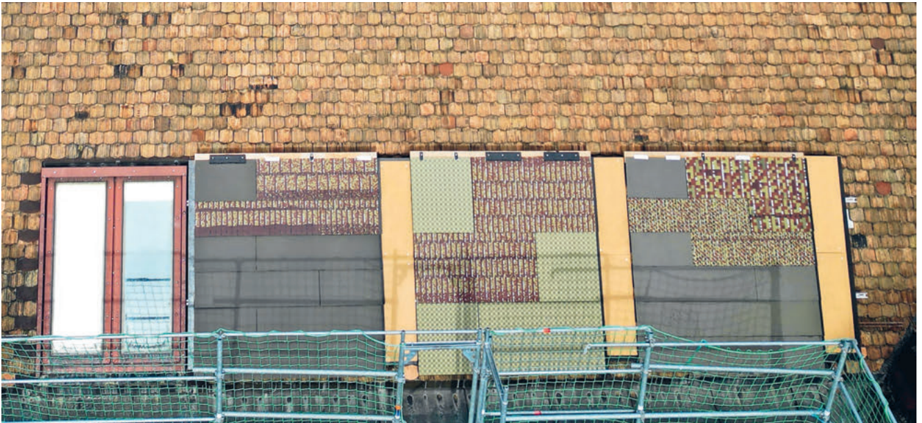
Mock-ups in Basel: Aus der Distanz wirken die farbigen Solarmodule wie Ziegel. [Bild: zvg]
