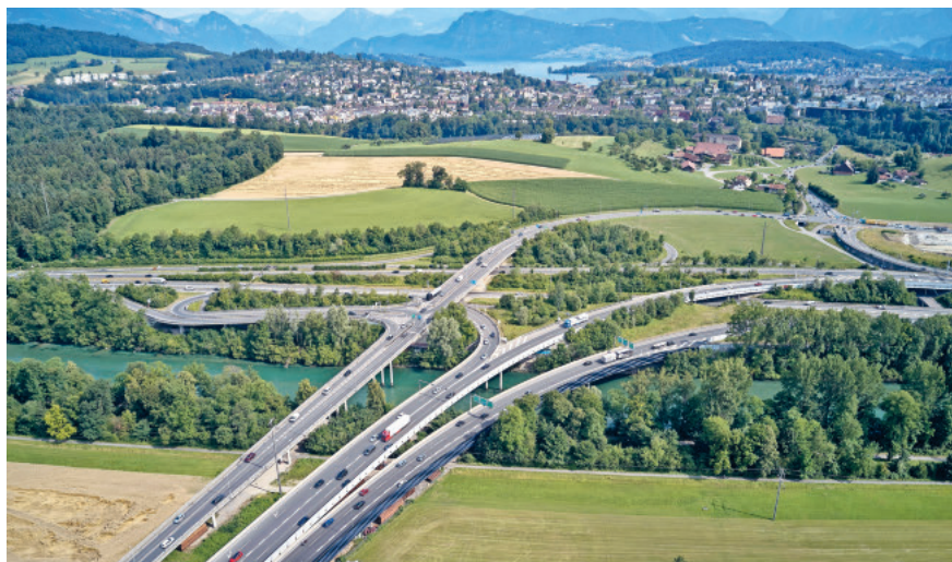
Blick auf den Autobahnabschnitt Emmen-Süd/lbach bei der Verzweigung Rotsee. Der Bereich ist Teil des Nationalstrassennetzes A2/A14 und spielt im Projekt Bypass Luzern eine zentrale Rolle. (Bild: Gemeinde Emmen, 2019)
