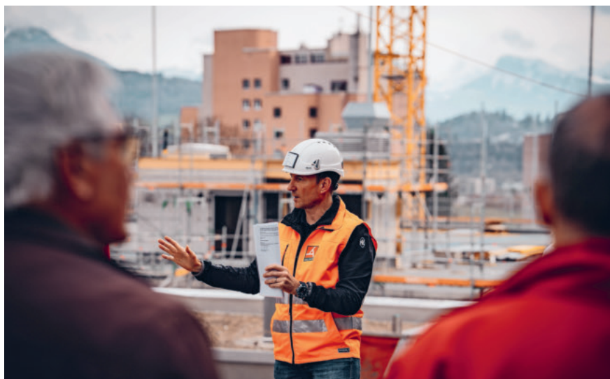
Projekt auf Kurs: Guido Kaufmann, Projektleiter Anliker AG, erläutert anlässlich einer Baustellenbesichtigung vom März 2026 den Stand der Bauarbeiten. (Bild: msc)
