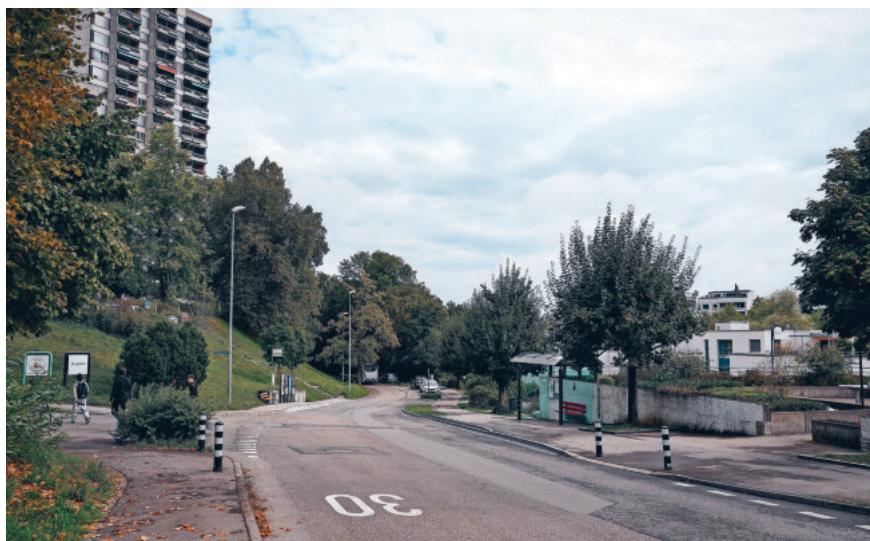
Bei der Bushaltestelle «Benziwil West» wird die Einfahrt links im Bild neu gestaltet und die Benziwilstrasse erhält einen neuen Deckbelag. (Bild: pbi)
