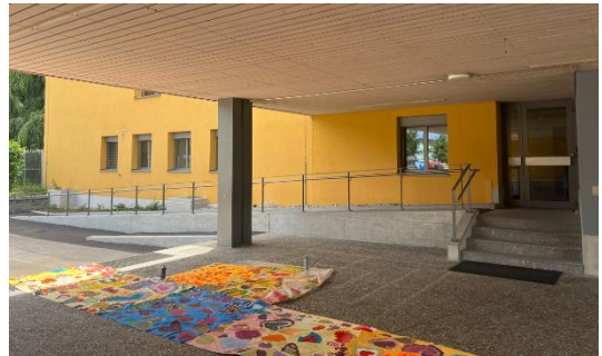
Abbildung 16: Neue Rampen und Treppe Spezialtrakt
