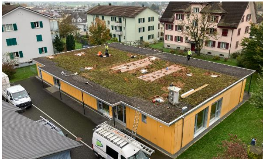
Abbildung 15: Arbeiten Flachdach Pavillon
