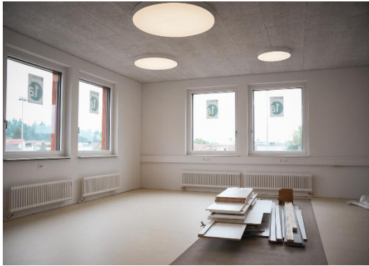
Abbildung 11: Neuer Raum Anbau
