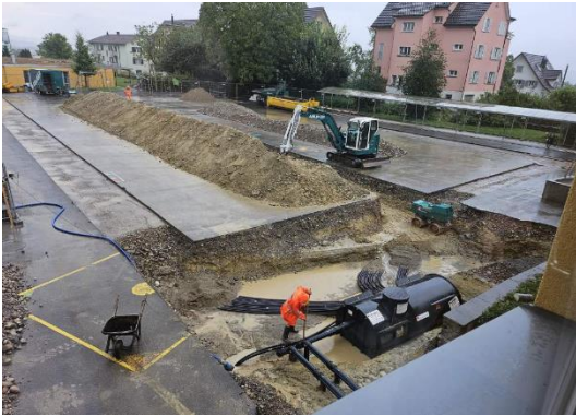
Abbildung 3: Erstellung Erdsonden
