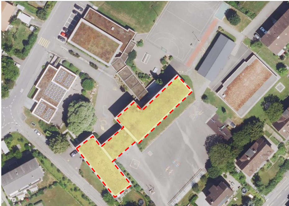
Abbildung 19: Luftbild mit schadhaften Flachdächern
