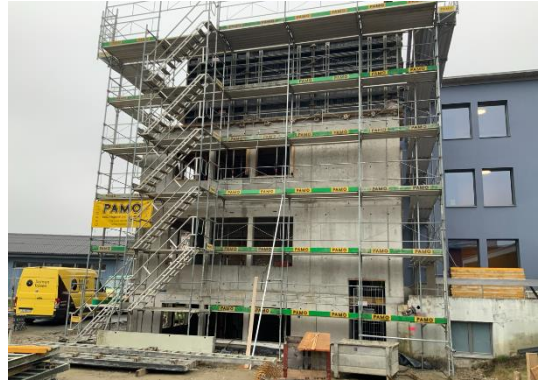
Abbildung 4: Rohbau des Anbaues
