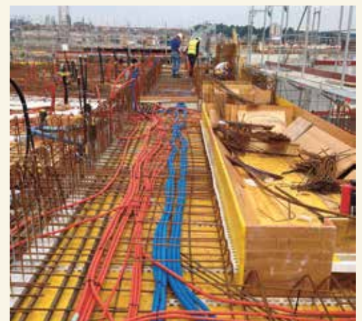
Ein Blick in das komplexe Innenleben der Baustelle. [Foto: Steiner AG]
