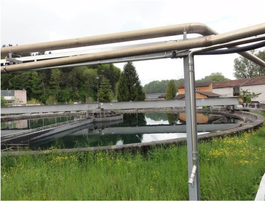
Abbildung 6-8: Fettwiese rund um die Klärbecken
