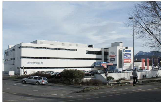
| WESTSEITE BESTEHENDES GEBÄUDE
