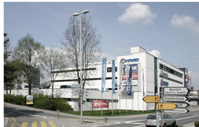
| SÜDSEITE BESTEHENDES GEBÄUDE
