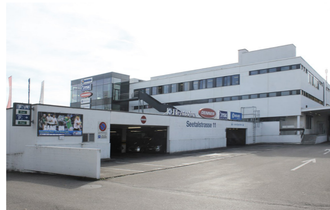
| NORDSEITE BESTEHENDES GEBÄUDE
