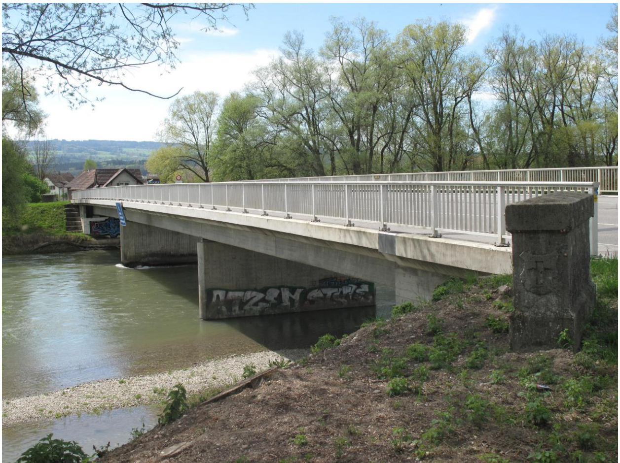
Beispiel: Reussbrücke in Obfelden ZH
