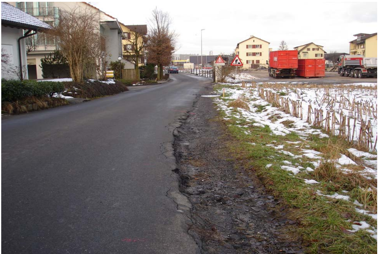
Bestehende Rathausenstrasse aus Richtung Brücke Rathausen. Rechts: Areal Wohnsiedlung Reusspark
