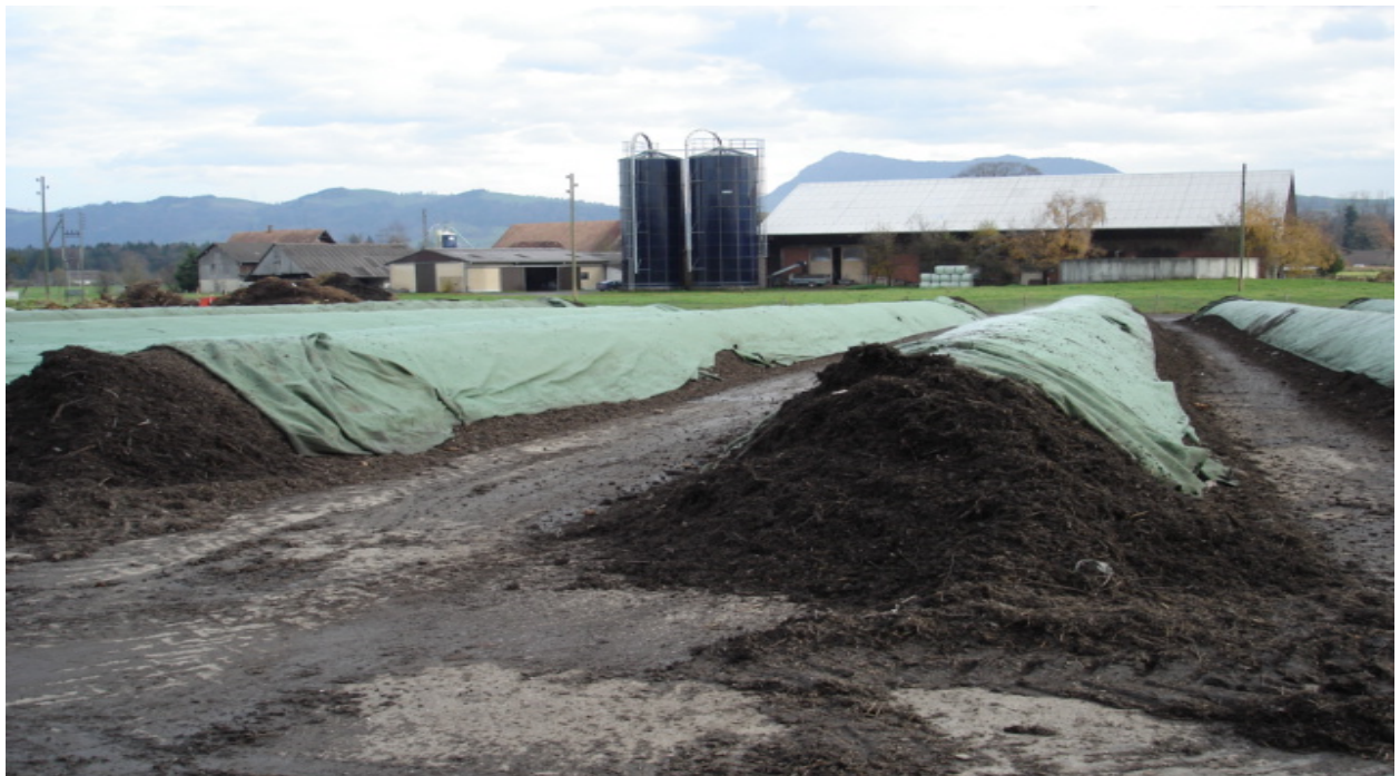
Bestehende Kompostieranlage in Waltwil
