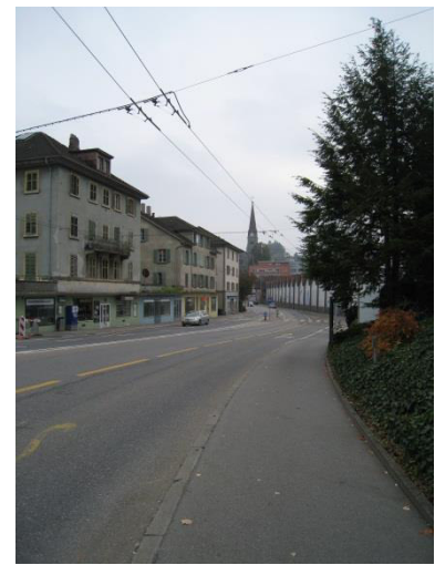
Abbildung 12: Hauptstrasse (Abschnitt 8 gemäss Abbildung 7)
