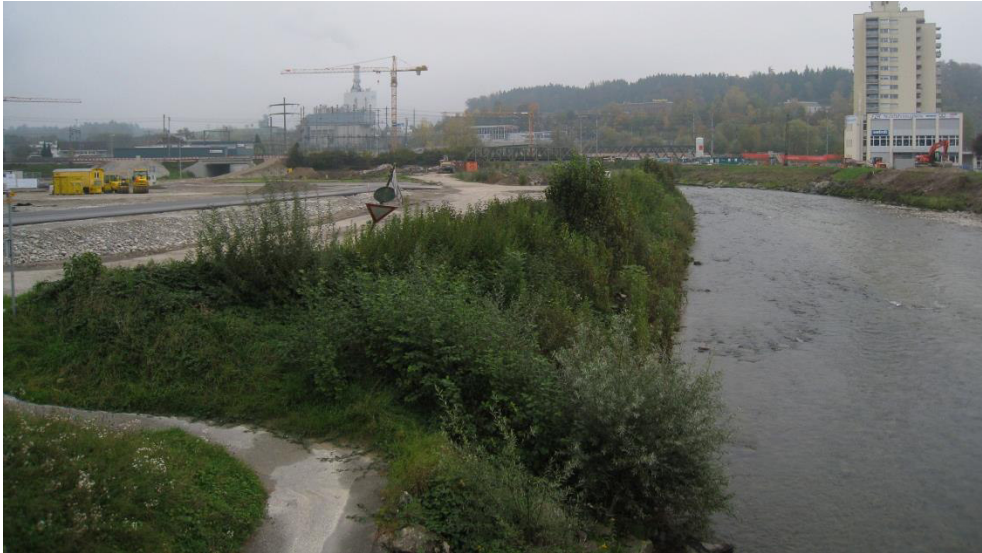
Abbildung 21: Kleine Emme im südwestlichen Bereich der Baufelder B1 - B3
