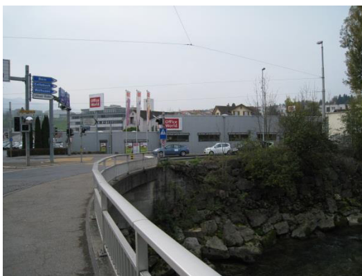
Abbildung 13: Einmündung Rothenstrasse (von rechts) (Abschnitt 9 gemäss Abbildung 7)
