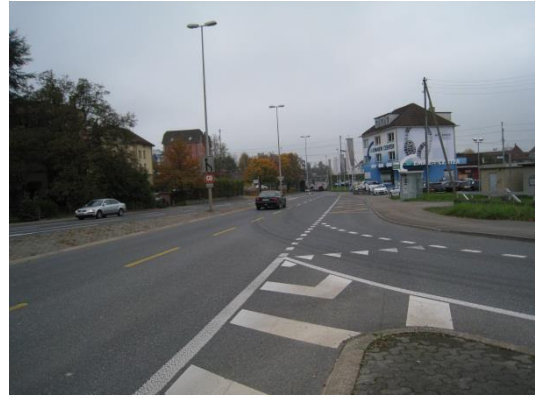
Abbildung 10: Seetalstrasse (Abschnitt 3 gemäss Abbildung 7)
