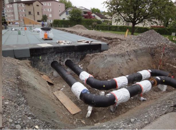
Die abgedichtete Bodenplatte und die Fernwärmeleitungen
