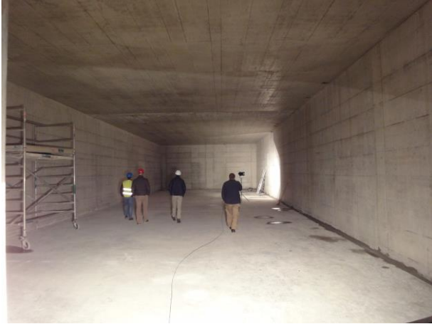
Das Innere der Fernwärmeübergabestation
