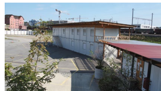
Die ehemaligen Baucontainer stehen für die Nutzung durch Emmerinnen und Emmer bereit.
