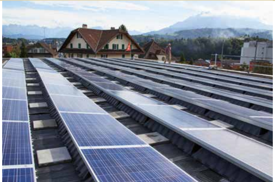
Fotovoltaikanlage Schulhaus Krauer
