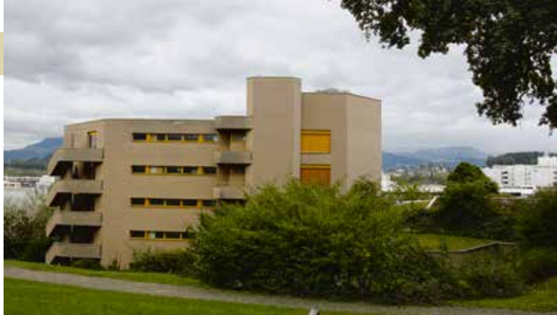
Die Gebäude auf der Herdschwand sollen frühzeitig abgerissen werden.
