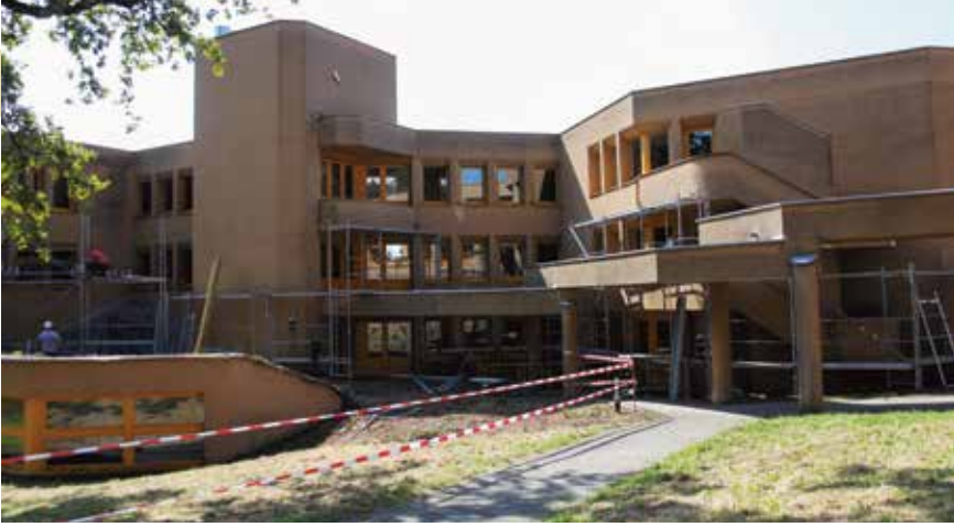
Der Rückbau des Betagtenzentrums Herdschwand verzögert sich.
