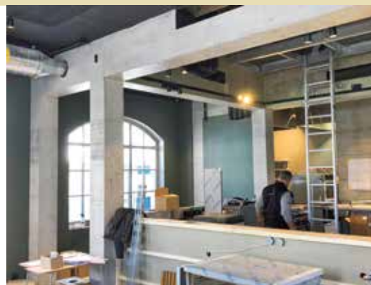
Noch ist Bauphase beim Tramhüsli.
