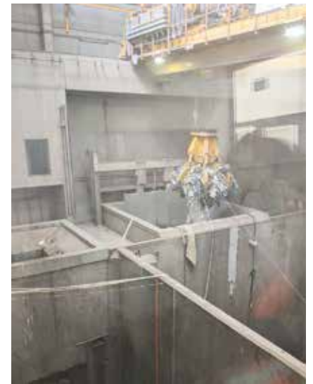
Riesige Greifarme werfen den Kehricht automatisch in den Häcksler zur Weiterverarbeitung.
