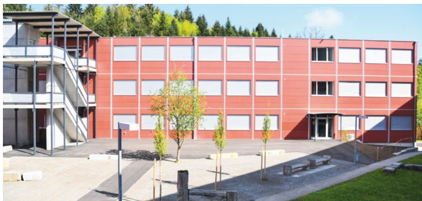
Der Modulbau am provisorischen Standort auf der Schulanlage Erlen wird nur vorübergehend für Fachunterricht, Gruppenarbeiten und die Integrative Förderung genutzt. (Bild: pbu)
