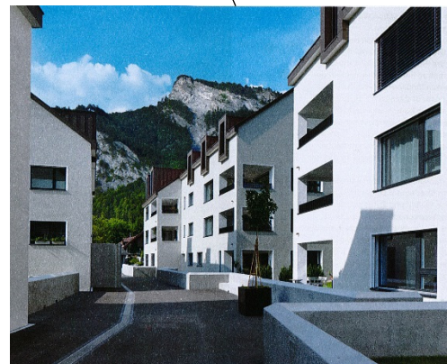
Beispiel Fläsch, dichtes, dörfliches Wohnen: kleinteilige Gebäudestruktur, Strasse als Begegnungszone, grundgebundenes Wohnen im EG (Bild HP)
