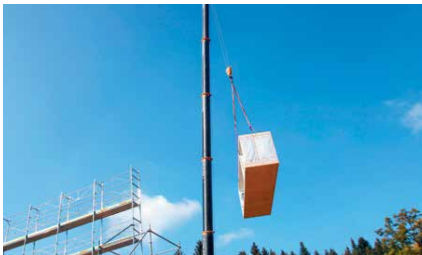
Bald schweben die Holzmodule vom provisorischen zum definitiven Standort und werden die Schulanlage Erlen um den vierten Trakt ergänzen. (Bild: fco)
