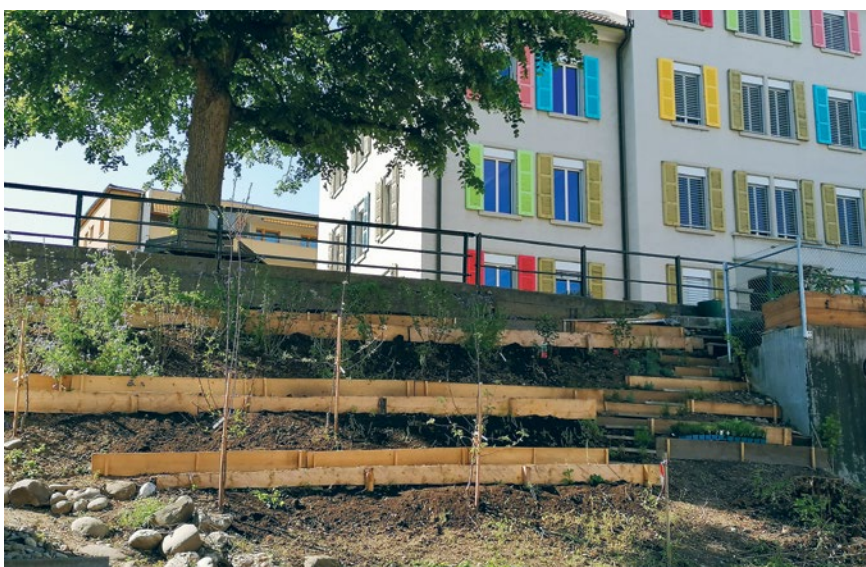
Hang gesichert, Sträucher und Bäume eingepflanzt.
