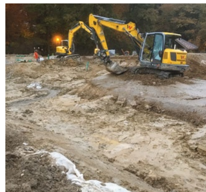
Bauarbeiten für den Pump Park Emmen beim Mooshüsli. Wegen des nassen Untergrunds können die Arbeiten vorerst nicht fortgeführt werden. (Bild: zvg)
