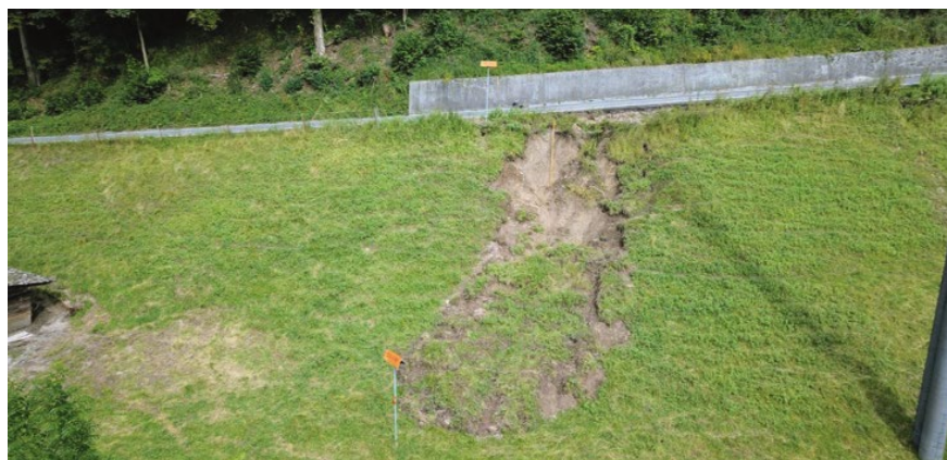
Luftaufnahme der westlichen Bergstrasse mit Hangrutsch. (Bilder: Stadt Luzern)
