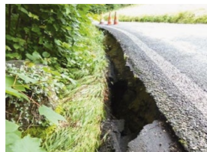
Der Asphalt an der östlichen Bergstrasse ist nach der Rutschung überhängend.
