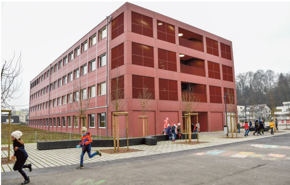
Neuer Schulraum zum Jahresauftakt: Anfang Januar 2021 konnten alle Klassen der Primarschule Erlen in den neuen, vierten Gebäudetrakt einziehen. (Bilder: rra)
