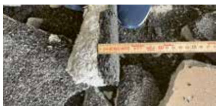
Die mit Teeröl getränkte Kornspreu (schwarz) wurde restlos aus den Böden der Unterrichts- und Aufenthaltsräume entfernt.
