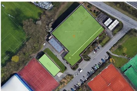
Abbildung 12; Photovoltaik-Anlage Sporthalle Rossmoos
