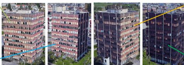
Abbildung 16; Photovoltaik-Anlage Fassade Verwaltungsgebäude
