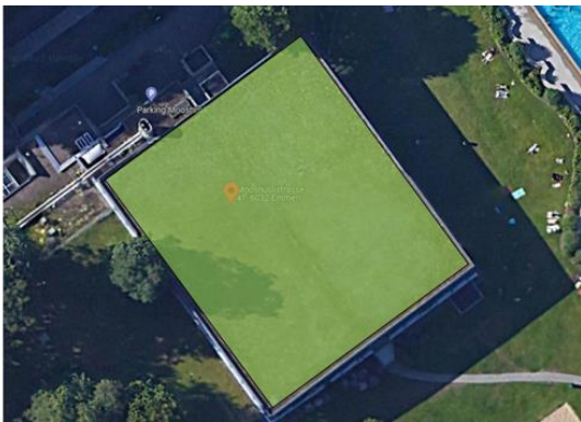
Abbildung 14; Photovoltaik-Anlage Hallenbad Mooshüsli
