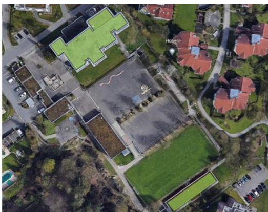
Abbildung 10; Photovoltaik-Anlage Schulanlage Hübeli (bestehende Gebäude)
