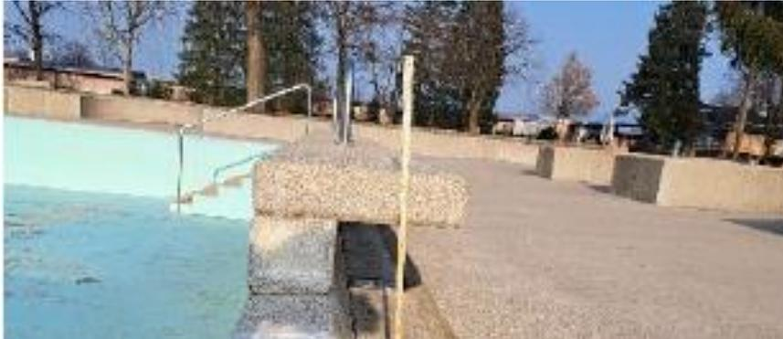
Abbildung 13: Sprungbänke beim Nichtschwimmerbecken, welche aus Sicherheitsgründen entfernt werden müssen
